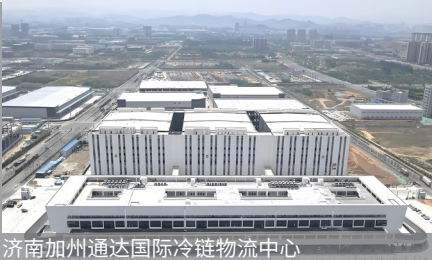
济南加州通达国际冷链物流中心
